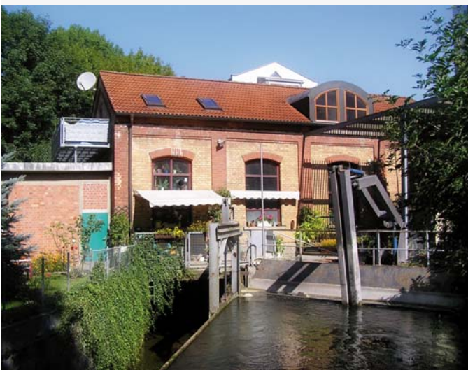
Unmittelbar am Grundstück, direkt im Grünen, befindet sich das historische Wasserkraftwerk am Schäfflerbach.
